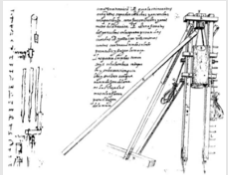
Figura 2. Máquinas para clavar pilotes en Leonardo (García, 1996)
