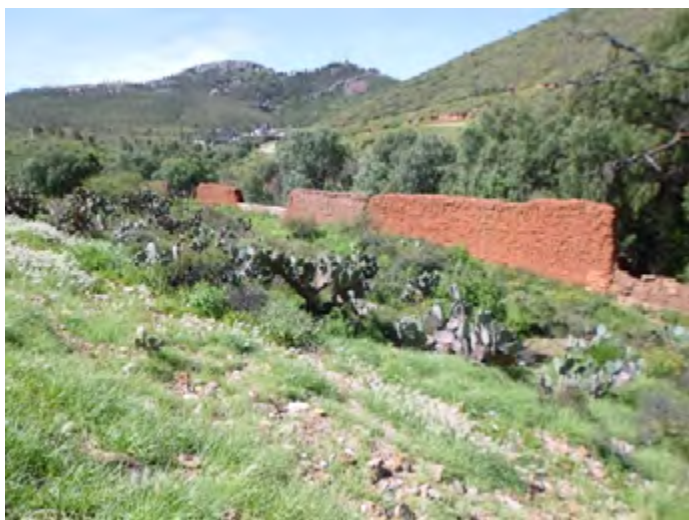
Figura 4: Vista de los dos tipos constructivos, destaca el adobe rojizo de la segunda el cual es deleznable y de mala calidad.
