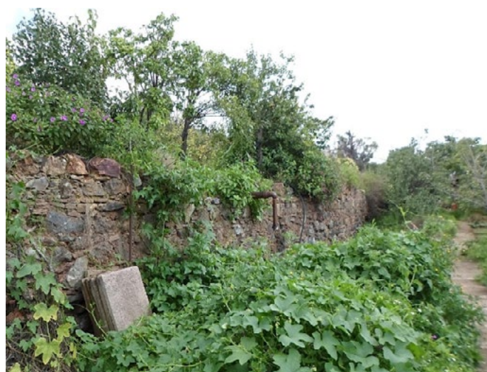
Vista del sistema de terrazas interiores de la Huerta de La Pinta, construidas a partir de piedra de mina.
