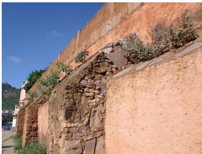
Vista del sistema constructivo de la Huerta de La Pinta a base de contrafuertes.
