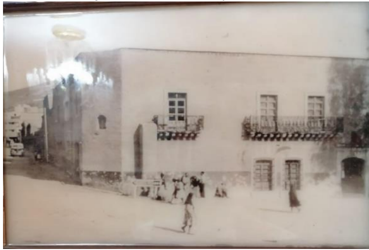
Imagen 1. Edificio Conejera Luévano
