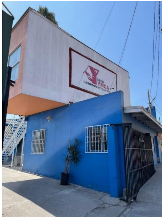
Fig. 4. Exterior de Casa YMCA Tijuana.
