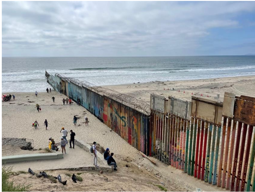
Fig. 2. Muro fronterizo en el tramo de la Playa de Tijuana.
