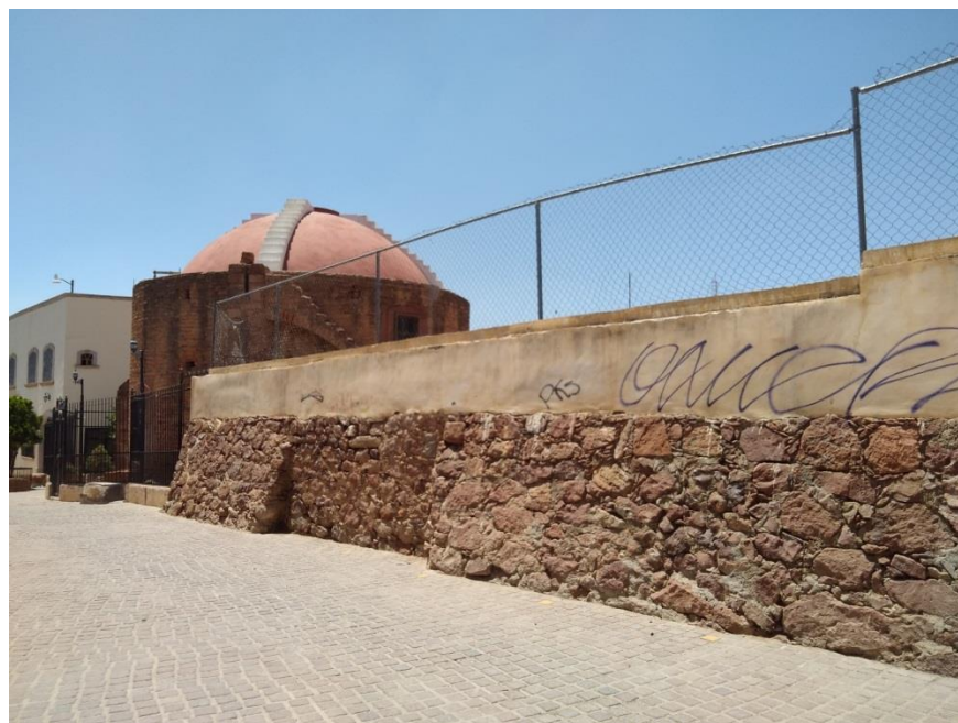
Figura 11. Muro que perteneció a los “Toriles”, actualmente es una de las bardas que rodean la Escuela Primaria Fernando Soria
