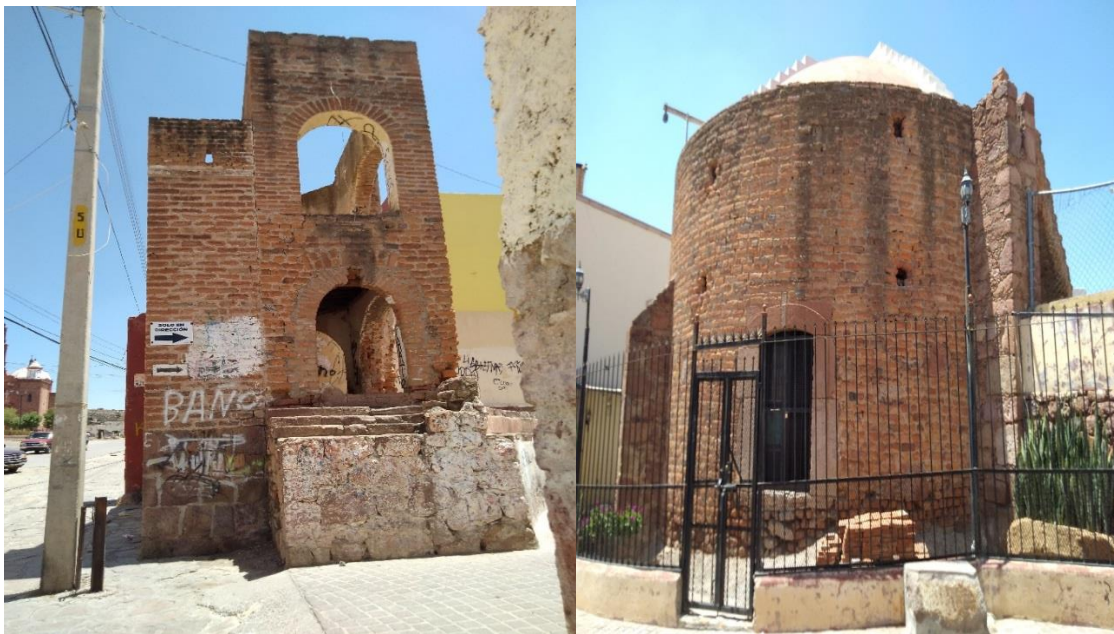
Figura 8. A la izquierda “El Mirador” del casco de la Hacienda de Trancoso. A la derecha se observa la privatización del inmueble “La Tolva”
