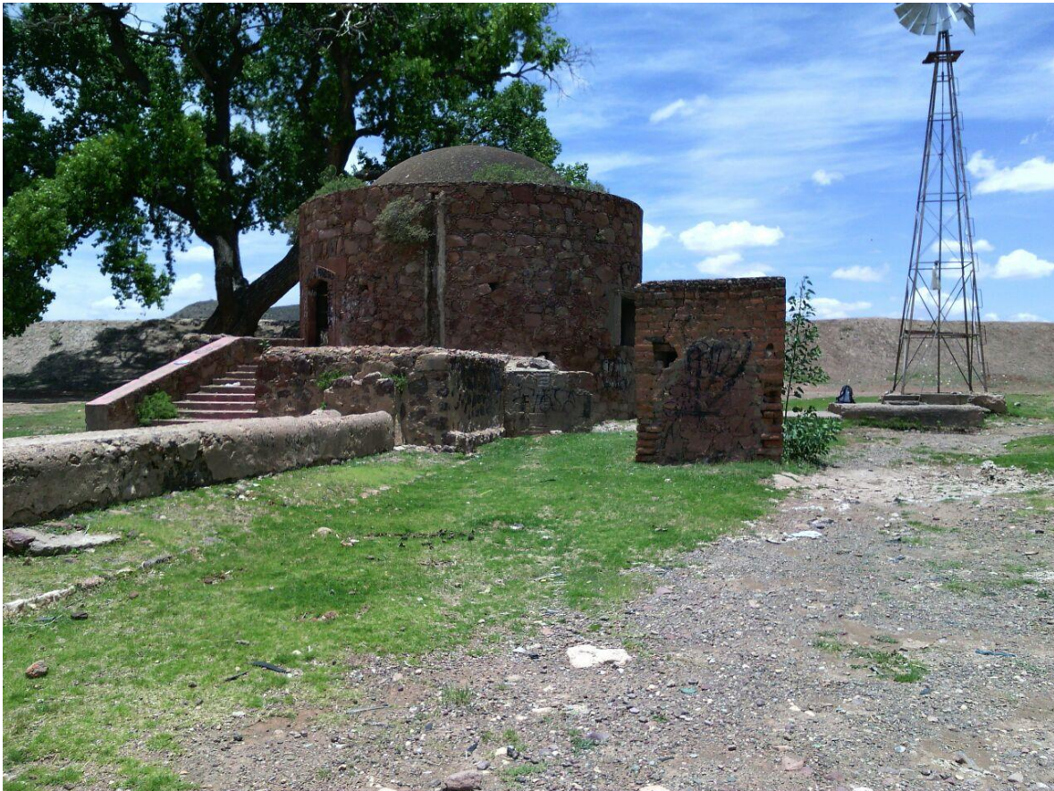
Figura 4. Estado actual del sitio de “San Isidro”, se observa la noria con un abrevadero y la estructura de la derecha es la entrada a un sistema de irrigación subterránea
