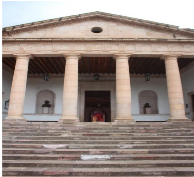
Figura 5. Escaleras 4 (fotografía por Jorge Eduardo Ortiz Marcial, Abril 2017).
