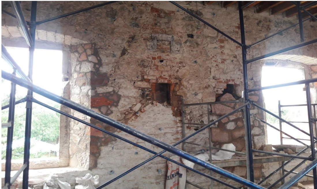
Figura 12. Sala de Laboratorio indicada en el “Plano de la Planta Alta y Fachada Principal de la Escuela Práctica de Minas y Metalurgia” (sala contigua a ensaye y en proceso de restauración) (fotografía por Jorge Eduardo Ortiz Marcial, Octubre, 2017).
