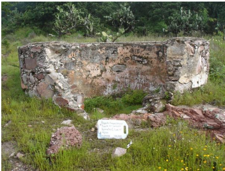
Figura 8. Aljibe de cal y canto.
