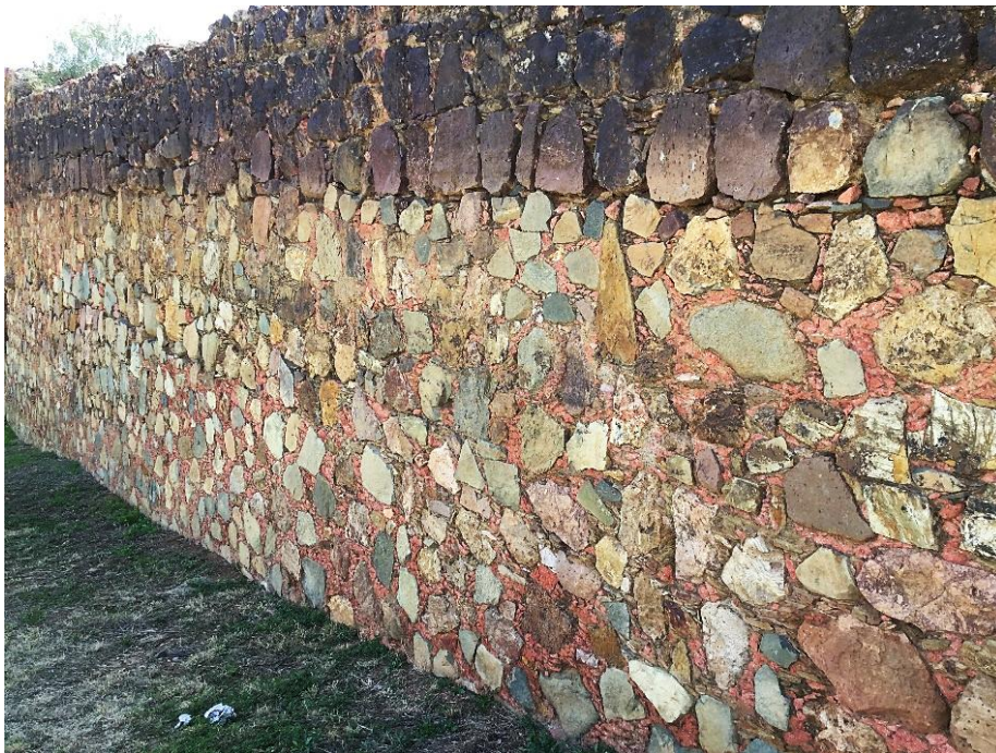
Figura 3. Acercamiento a las rocas de construcción de la represa (tomada por Edwing Murillo, 22 febrero de 2020)
