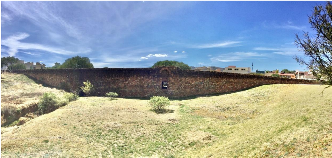
Figura 6. Panorámica de la represa, vista Norte (tomada por Edwing Murillo, 7 de marzo de 2020)
