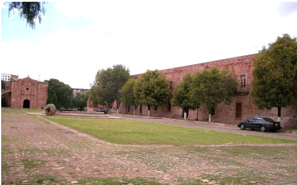
Figura 9. Parte sur del casco de la ex hacienda, antes de ser dividido por bardas. En primer plano el patio de lavado, a la derecha la fachada y acceso principal, al fondo la capilla (tomada de https://www.flickr.com/photos/53634686@N05/4978026965/in/photostream/ . Consultado 15 de abril de 2020)
