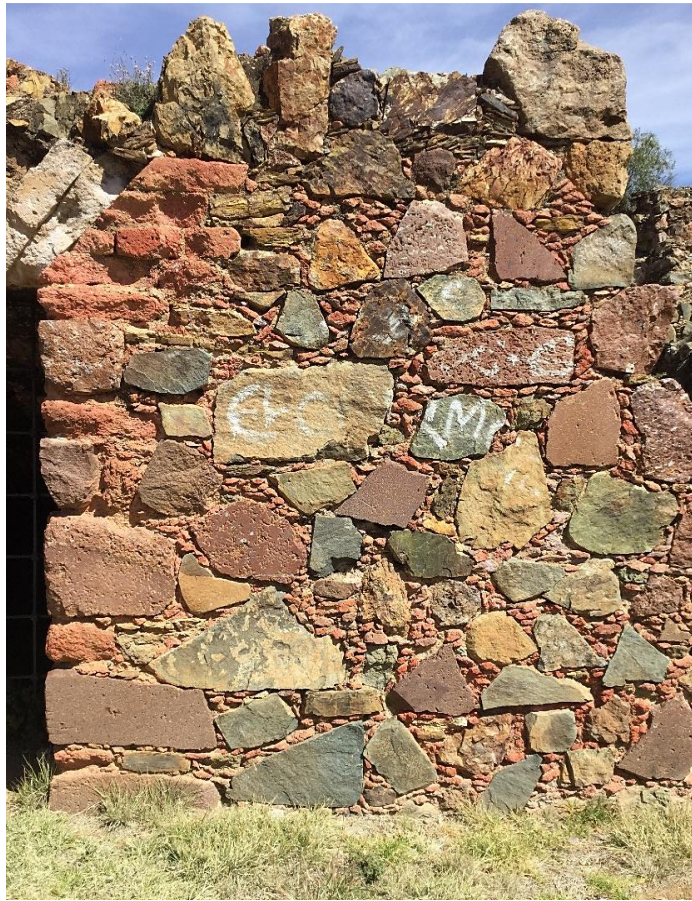
Figura 4. Material de construcción en la represa (tomada por Edwing Murillo, 17 febrero de 2020)
