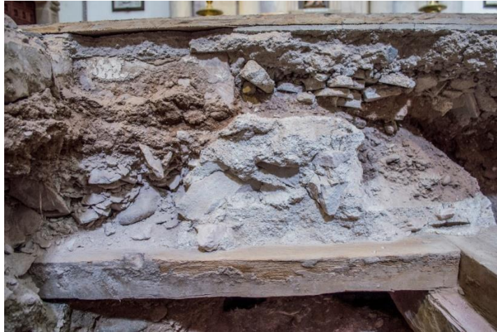
Figura 17. Sección del perfil Norte de la Unidad de excavación I. Al centro puede observarse, sobre la viga de madera, un enlucido de cal y arena, así como la mampostería de lo que aparentemente es un escalón. Fotografíó Alberto Peña
