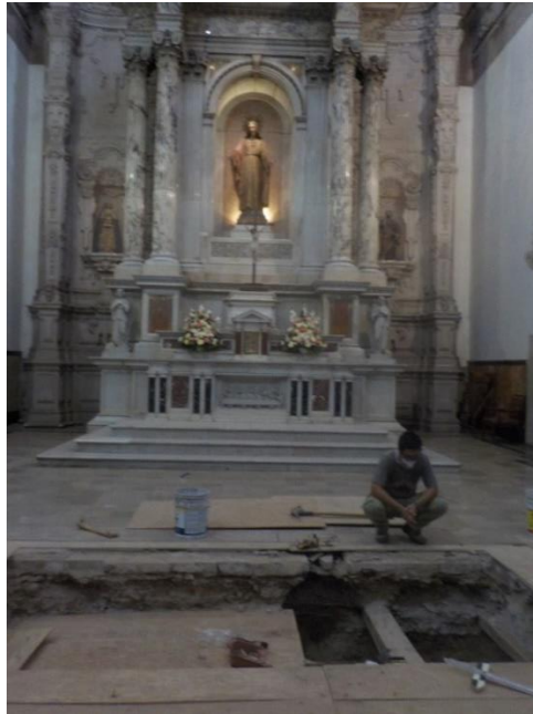
Figura 27. Perspectiva de la unidad de excavación en dirección al altar, obsérvese, por detrás del altar principal, el altar que fue colocado posterior al año 1889. Fotografíó Alberto Peña
