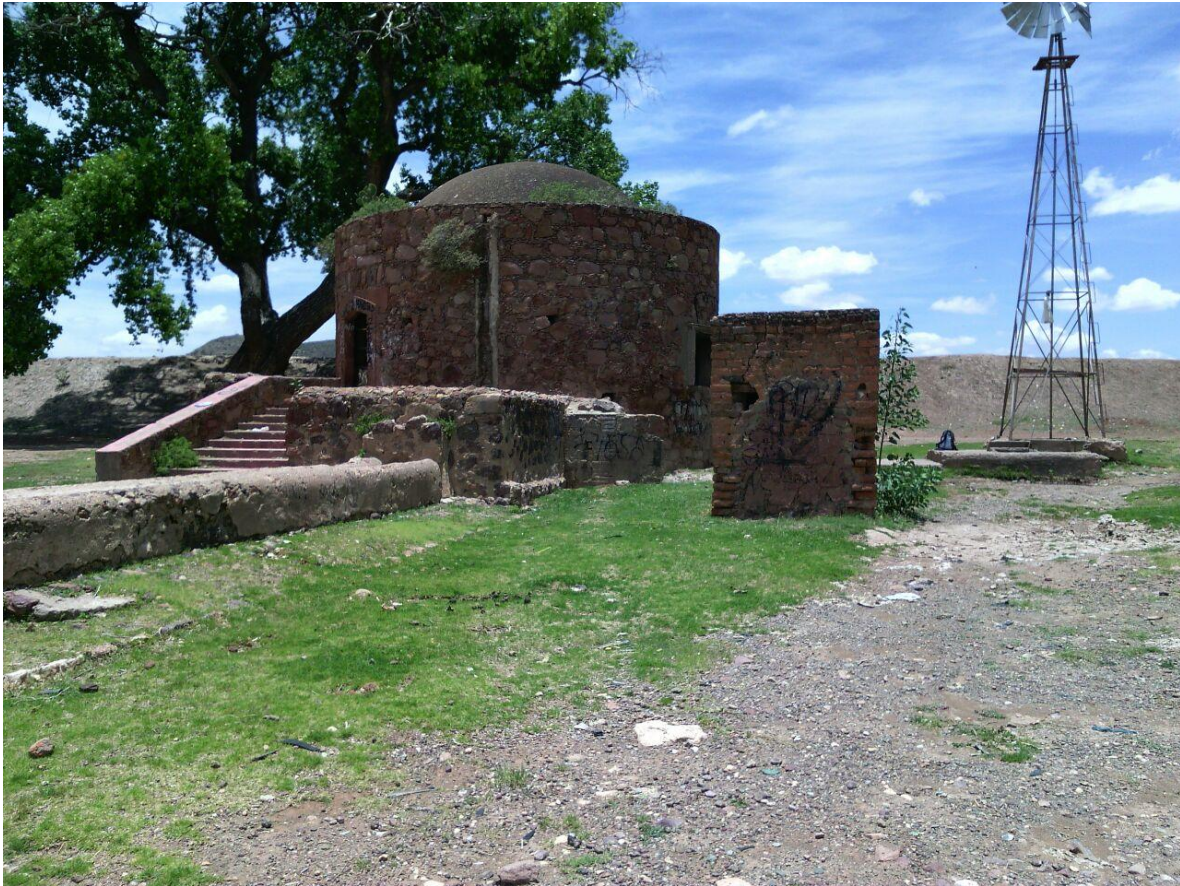
Figura 4. Estado actual del sitio de “San Isidro”, se observa la noria con un abrevadero y la estructura de la derecha es la entrada a un sistema de irrigación subterránea
