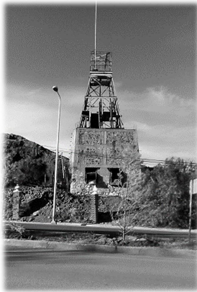
Figura 7. Malacate de la Mina San Nicolás. La estructura metálica funcionó para acarrear materiales y depositarlos en la estructura de mampostería, la cual funcionaba como vertedero de los metales ya molidos, visible en primer plano.
