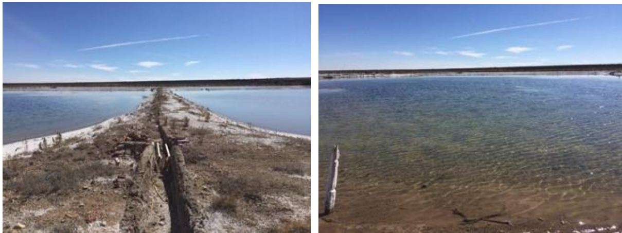
Figura 2: Canal para el llenado de las piletas cristalizadoras (izquierda) y pileta cristalizadora con salmuera (derecha). (Fotografía del autor, Salinas Viejas de Santa María, Santo Domingo, S. L. P., febrero 2016).
