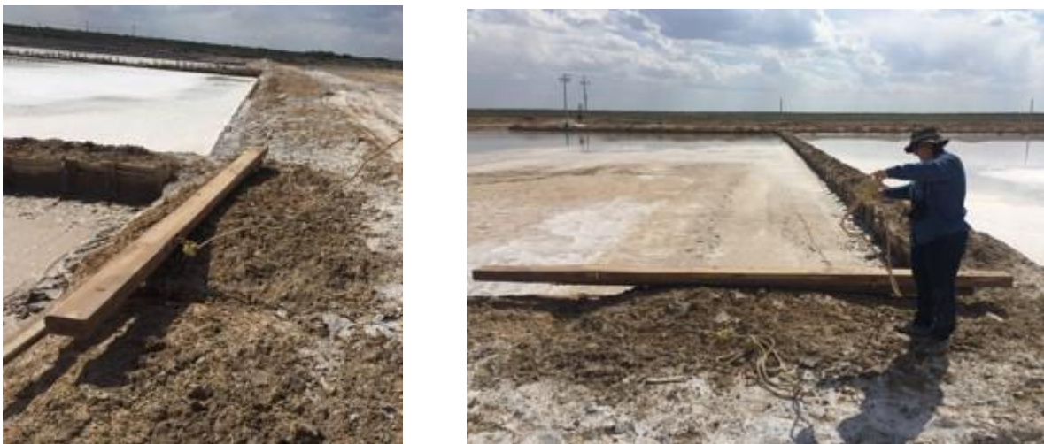
Figura 5: Tablón para el alisado de las piletas (izquierda), vista frontal (derecha) (Fotografía del autor, laguna Saldívar, Santo Domingo, S. L. P., abril 2018)
