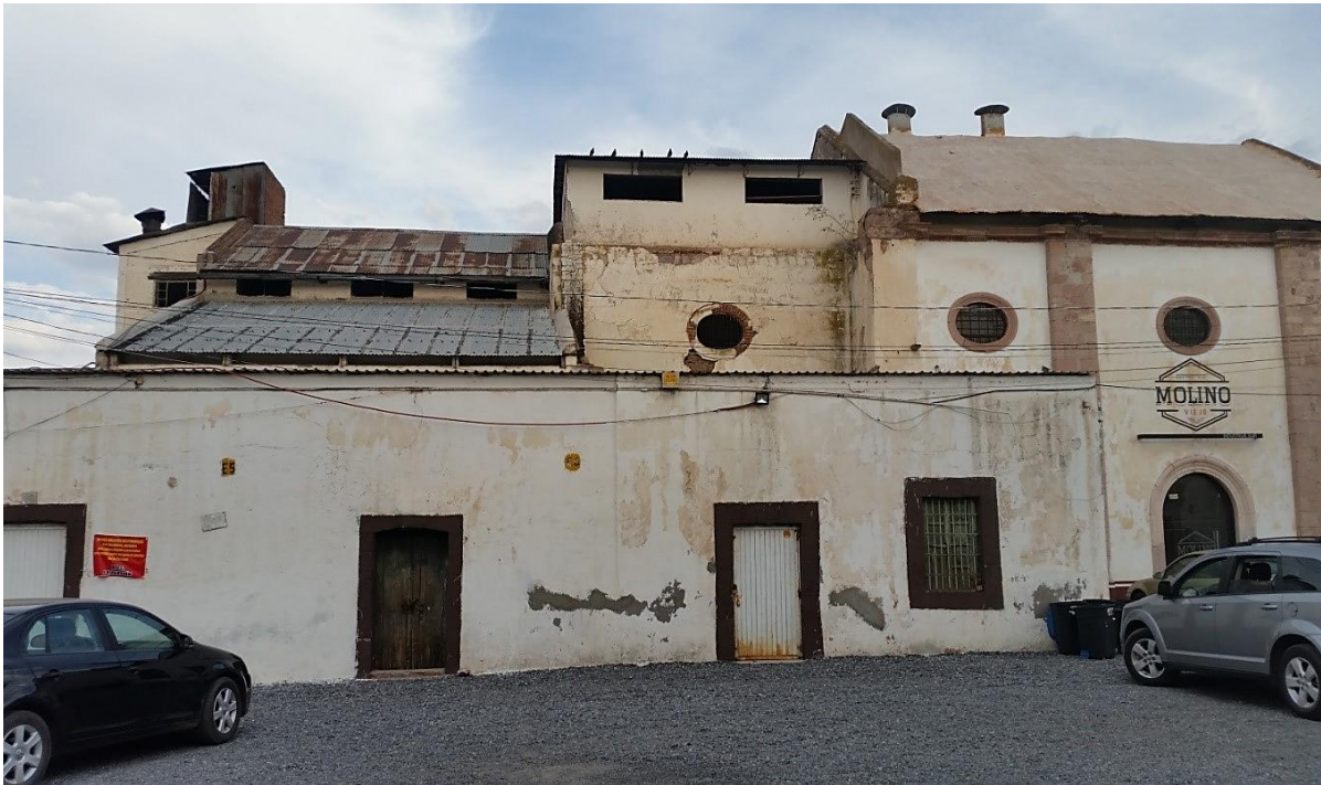
Figura 3. Fachada principal de la Harinera
