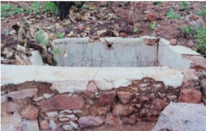
Figura 2: pileta asociada al cerro donde se puede ver que ha sido sometida a mantenimiento y en la parte superior también destaca la tubería de arcilla
