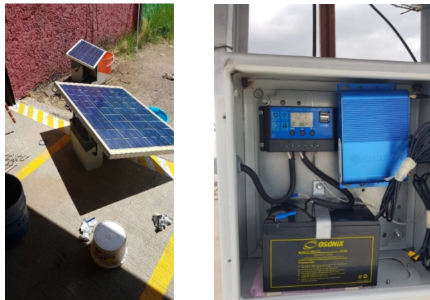
Figura 9. Instalación del equipo electrónico y Gateway (Derecha) y el panel solar (izquierda).
