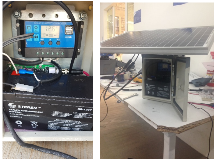
Figura 7. Instalación del equipo electrónico en el gabinete (izquierda) y el panel solar (derecha)
