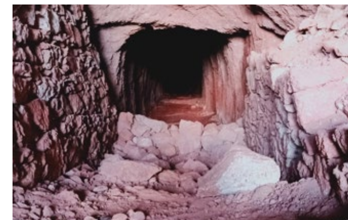
Figura 4: Entradas a socavones aparentemente talladas a mano
