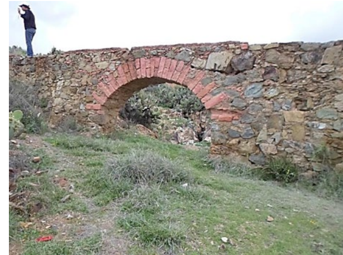
Figura 2: Vista del acueducto donde se observan las fases constructivas y un arco.
