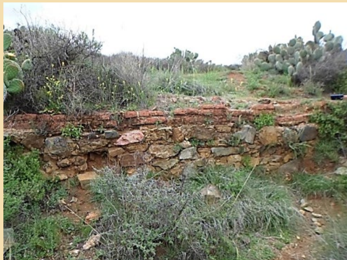
Figura 1: Muro de acequia, donde se observan dos fases constructivas.
